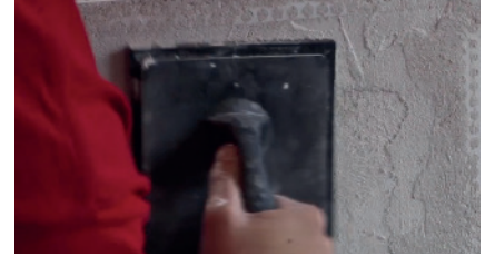
3 Skamol Smooth Plaster in einer gleichmäßigen Schicht von 1,5-3mm auftragen.
