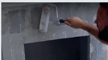
2 Applicera Skamol Primer på de ytor på SkamoEnclosure Board som ska putsas.
