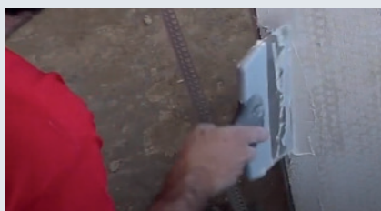
2 Applicera puts där Skamol Corner används.
