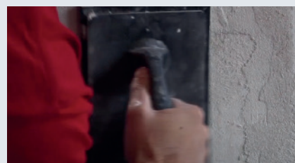
3 Puts kan läggas på ca 30 minuter efter applicering av Skamol Primer.
